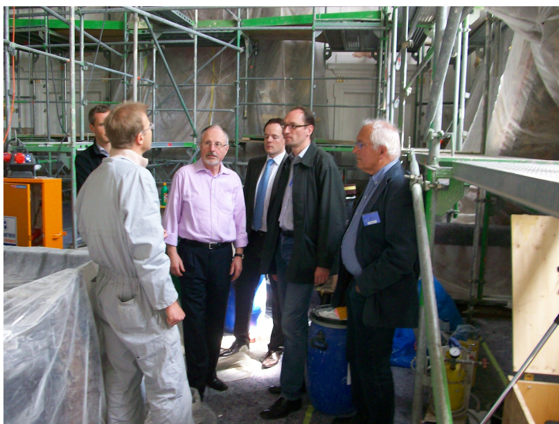
Abbildung 1: (von links) Diplom-Restaurator Peter Siebert, Ingenieur Fabian Reckmann (halb verdeckt), der als Ingenieur die architektonische Betreuung übernommen hat, Uwe Schweneke, Marco Dahl, Bernhard Seidenath und Ludwig Erlebach
